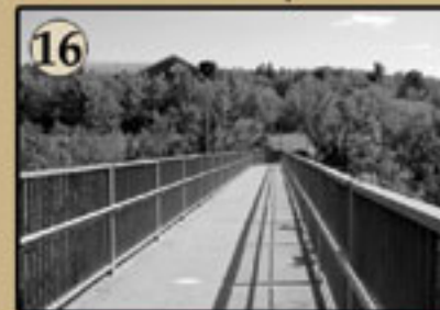
16 Une grande entreprise et son pont Rue St-Jacques
