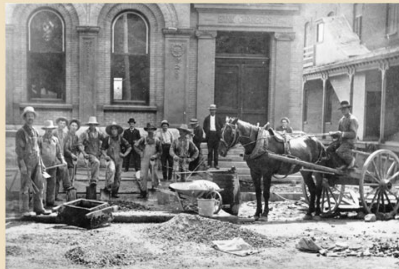
Des ouvriers fabriquent de nouveaux trottoirs en ciment devant l'édifice de la Eastern Township Bank, à l'été 1908. © Coll. Société d'histoire de la Haute-Yamaska
