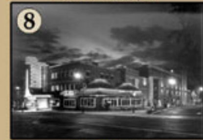
8 Le Palace 155, rue Principale
