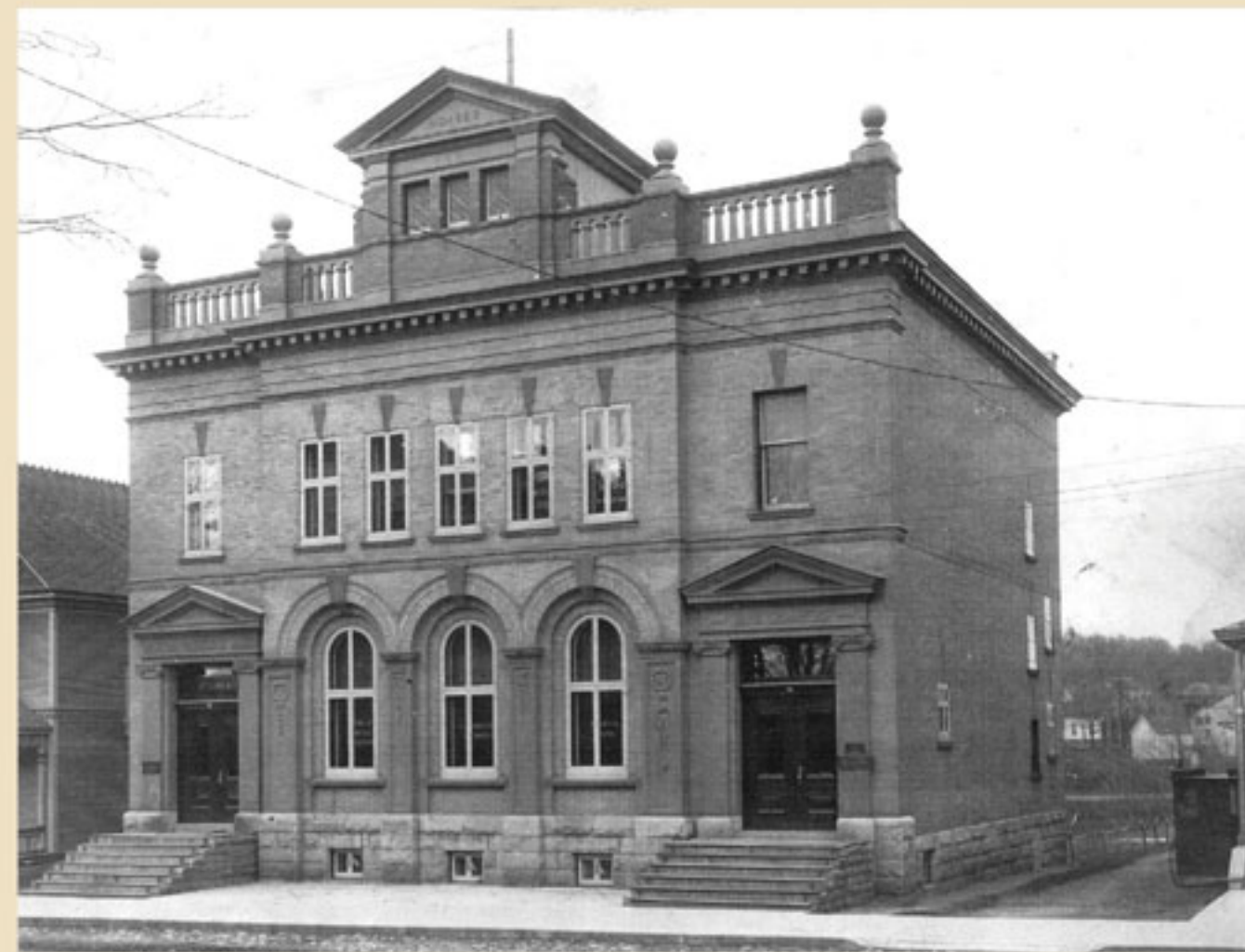
L'édifice de la Eastern Townships Bank, tel qu'il apparaît dans les années 1920. (© CIBC Archives)
