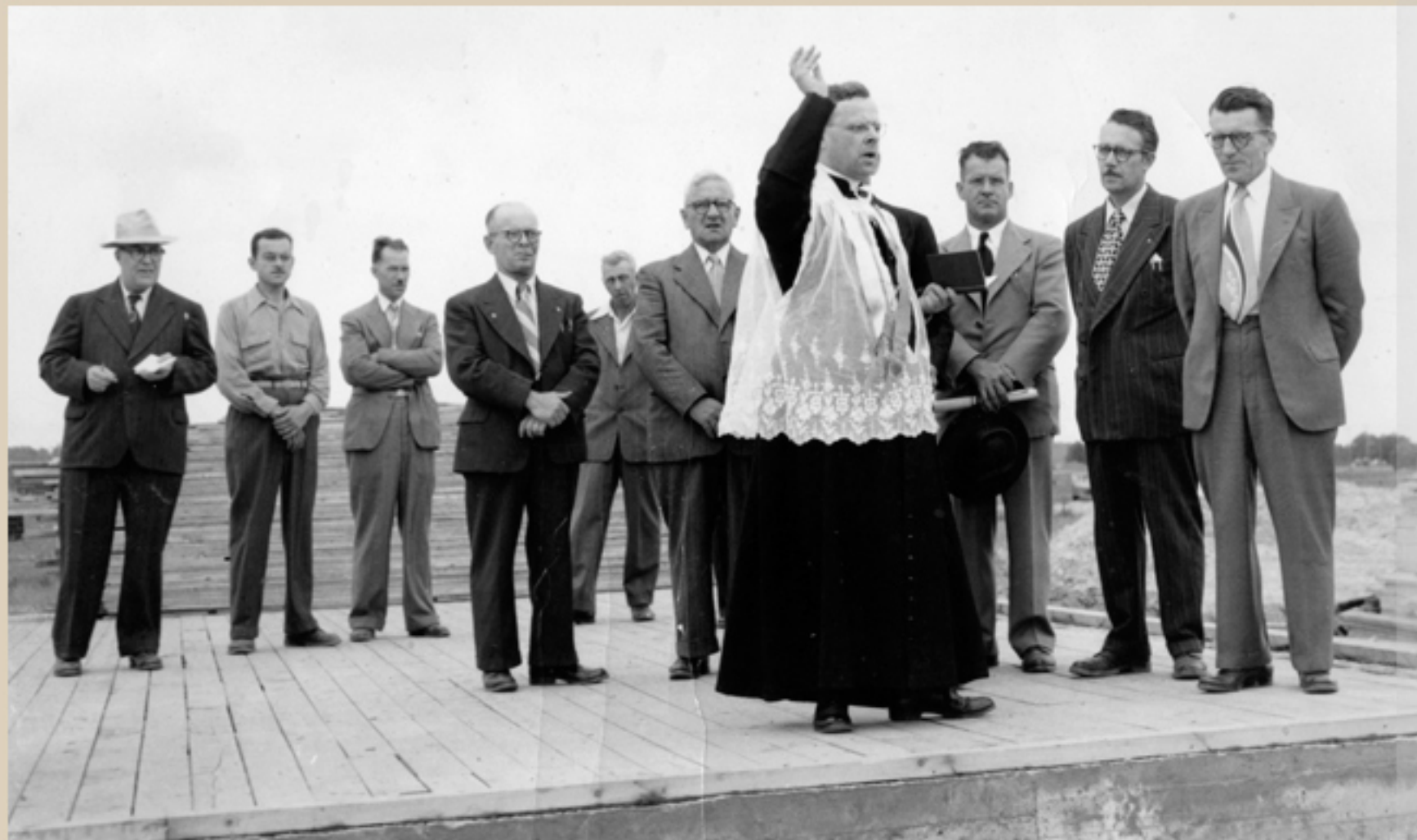
En présence de quelques conseillers municipaux, Téphesphore Dubuc, curé de la paroisse Saint-Eugène, appelle la protection du ciel sur la maison en construction de Laurent Guérin, dans la rue Pelletier. (Fonds Pierrette Guérin-Lussier)
